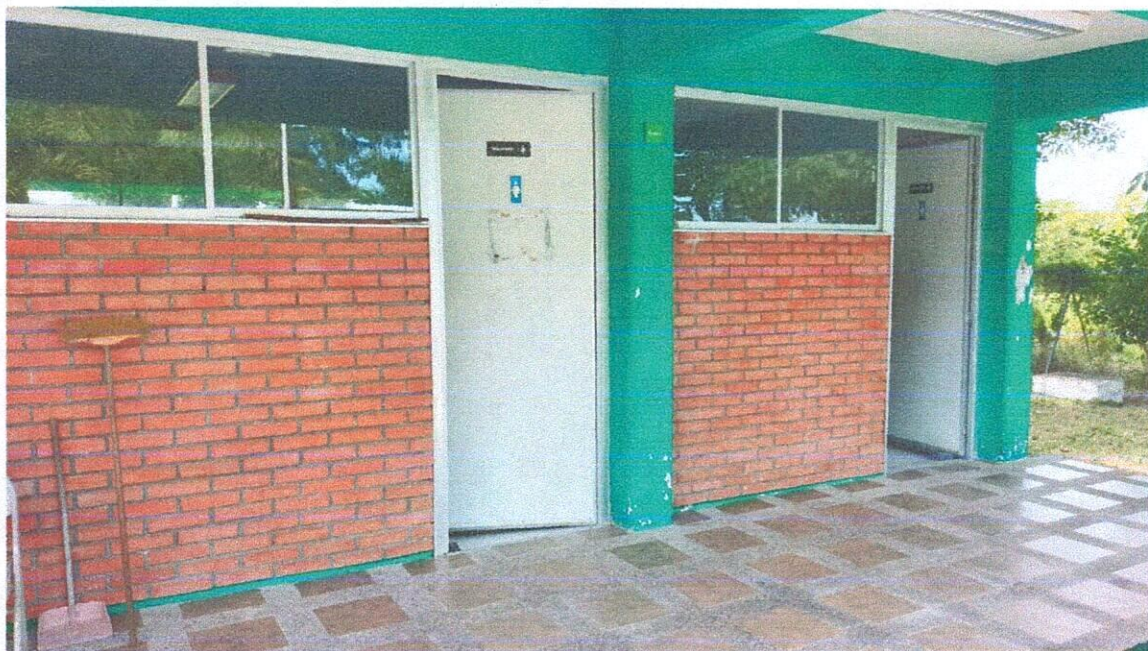
Baños del edificio
