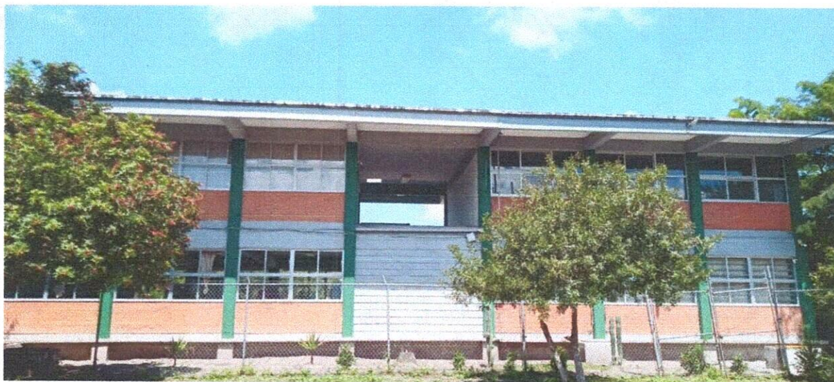
Parte trasera de las Instalaciones.
