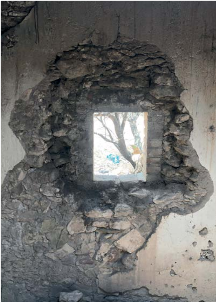
Figura 6. Vista interior de ventana en antiguo expendio de pulque a orilla del Camino. Fotos: G. Vela
